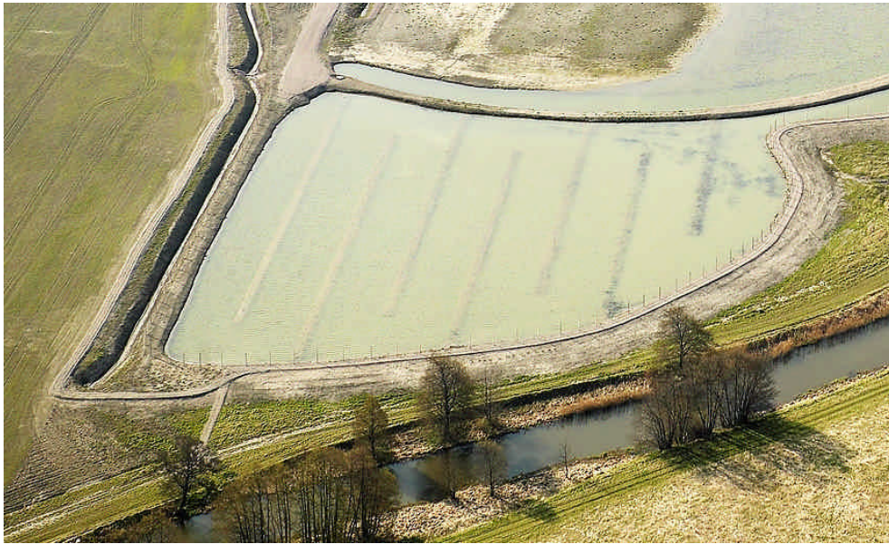
Figur 16. Exempel på grund våtmark där man skapat en lång uppehållstid för vattnet genom att anlägga flödesstyrande undervattensvallar. Trosa våtmark. Foto: Trosa kommun.
