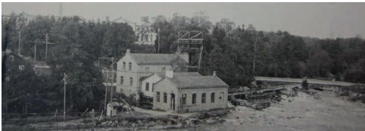
Bild 20. Svenska chokladfabriksaktiebolagets kraftverk vid Malfors. Anläggningen låg på södra stranden i höjd med Malfors norra kvarn och revs 1934. Strömsträckan till höger i bilden försvann när Malfors nuvarande kraftverk byggdes och utgörs numera av en betongskodd brant i torrårans nedersta del. Från Carstensson m fl (1992).
