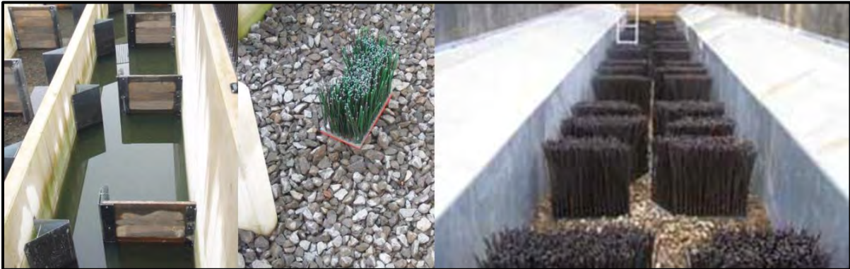
Figur 4. Exempel på en slitsränna med reglerbara slitsar och naturligt bottensubstrat i Nederländerna.
