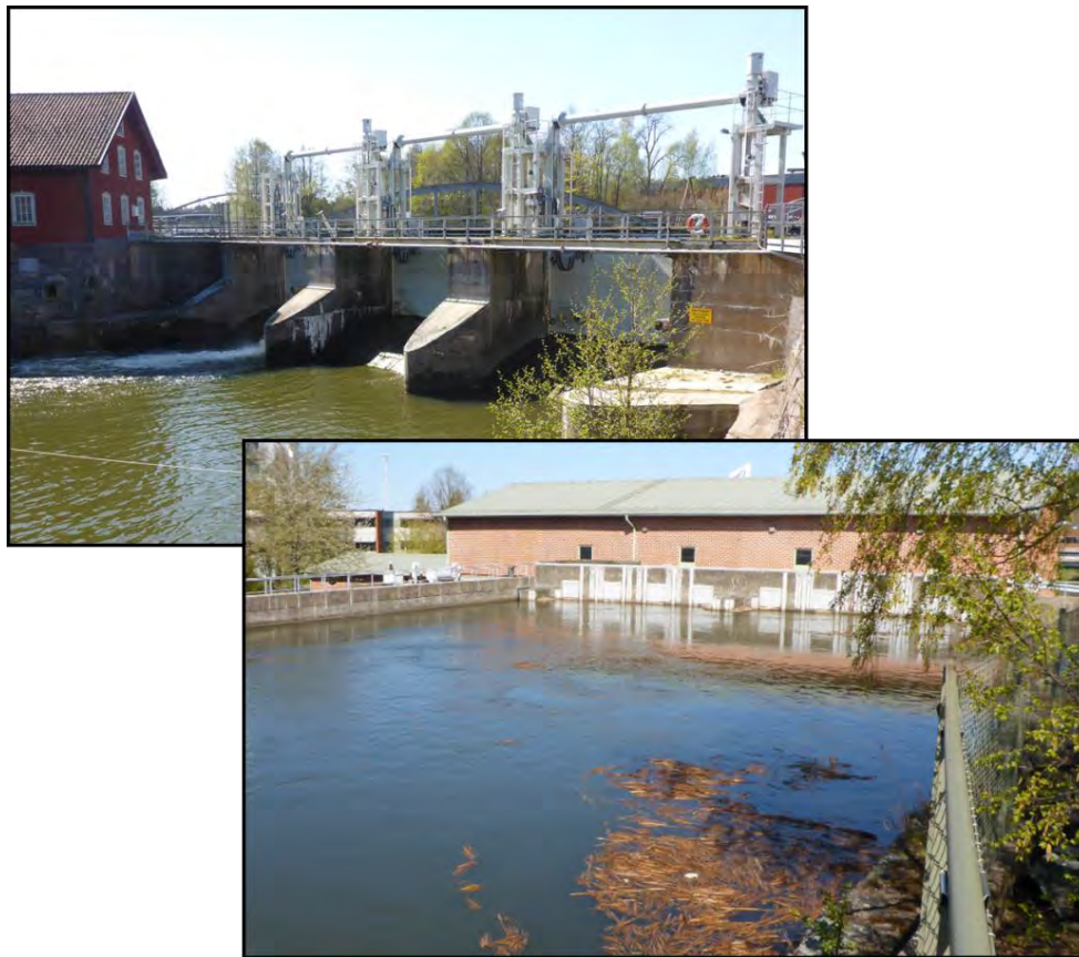
Bilder över spilldamm (övre) och kraftverksintag (nedre) vid Skärblacka 2014-04-23.
