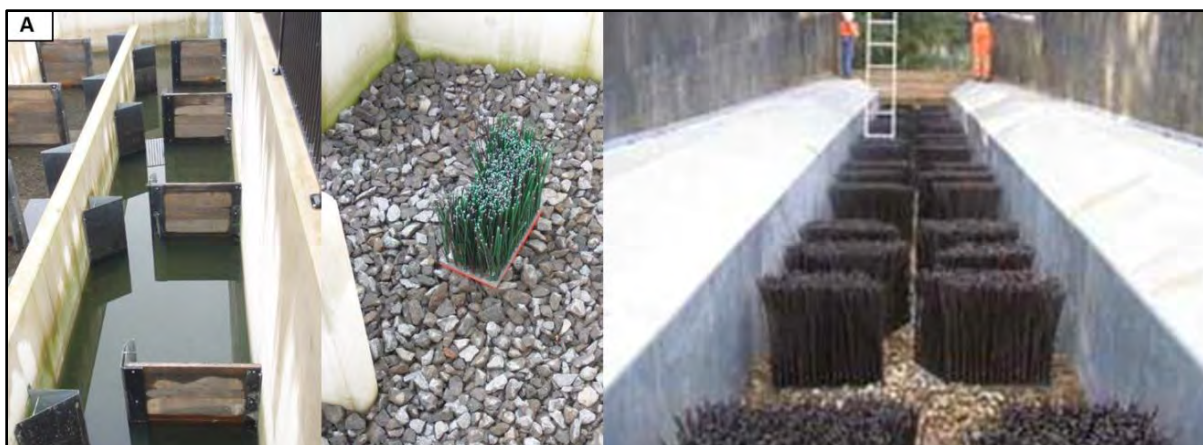
Figur 4. Exempel på en slitsränna med reglerbara slitsar och naturligt bottensubstrat i Nederländerna.
