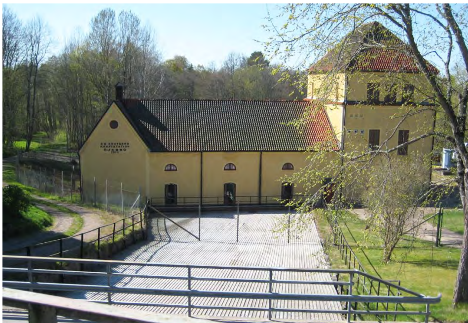
Nedströmsvy mot kraftverksbyggnad i Öjebro 2014-04-23.
