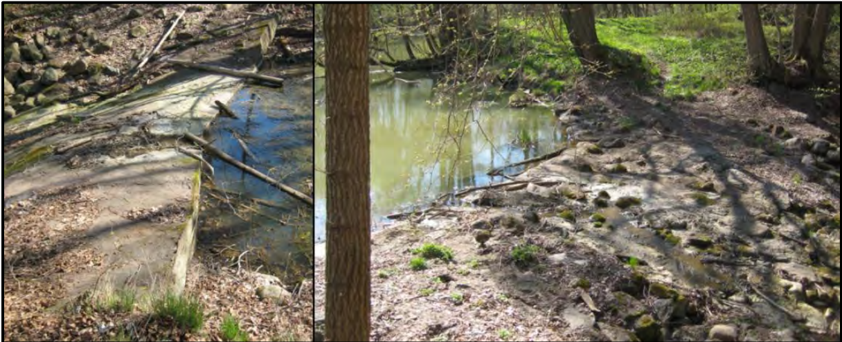
Figur 5. Betonggjutningar i den gamla fåran vid Jakobslund.
