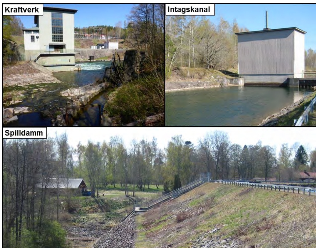
Vy över kraftverk (A), luckor vid intagskanal (B), samt utskovsdamm (C) vid Malfors 2014-04-22.
