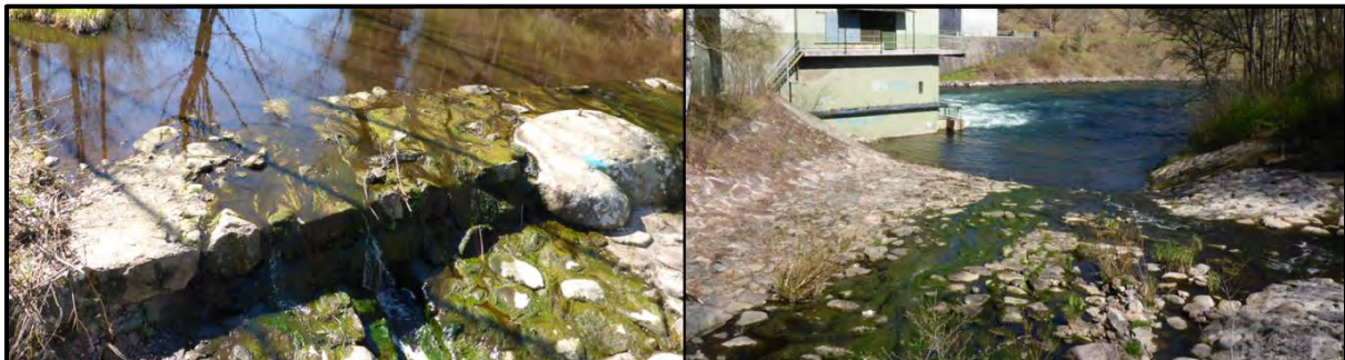
Figur 3. Spillfårans nedre del vid Malfors kraftverk.
