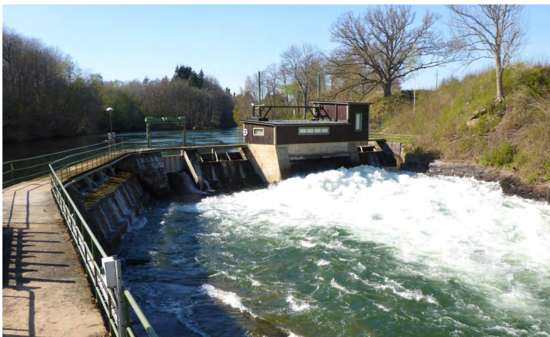
Uppströmsvy mot dammen vid Nykvarns kraftverk 2014-04-22 vid ett spill av 40 m 3 /s.
