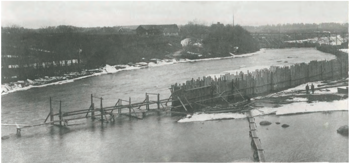
Bild 4. Svartån i samband med byggnationen av Svartåfors kraftstation.
