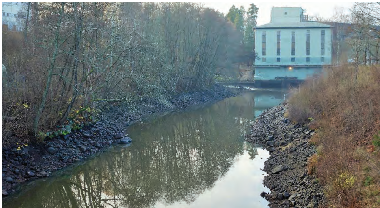
Bild 25. Malfors kraftstation och den fördjupade utloppskanalen 2014-11-11. Vid fototillfället var vattnet avsänkt för underhåll av Nykvarnsdammen. Fotografiet är taget på ungefär samma plats som bild 19. Foto Jonas Edlund.
