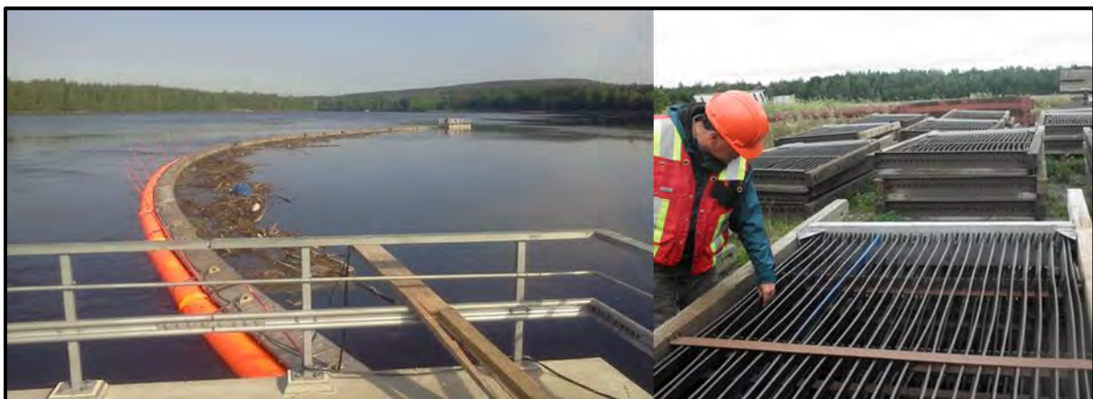
Figur 7. Ytavledare vid Norrforsdammen i Umeälven (vänster) och kanadensiska Louver-element (höger).
