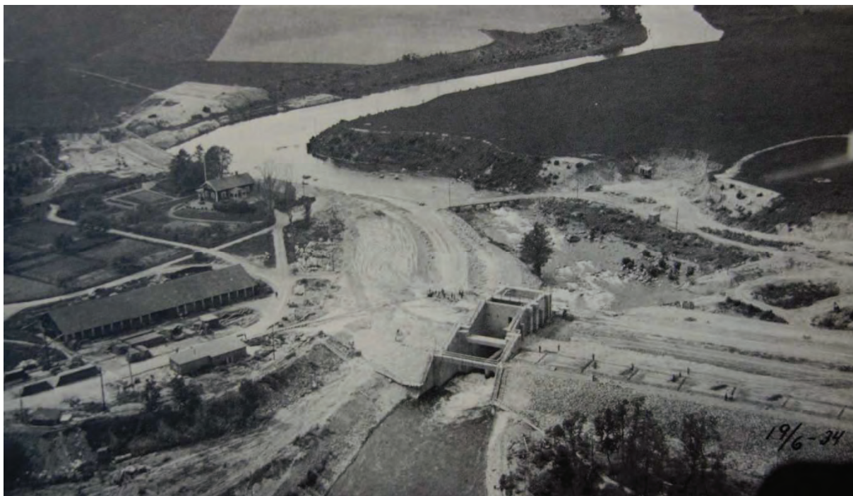
Bild 21. Flygbild från 1934 över området vid Ljungs tegelbruk när den stora jorddammen till Malfors kraftstation höll på att byggas. Vattnet rinner genom det nuvarande spillutskovet och området uppströms dammen har ännu inte dämmts in. Från Carstensson m fl (1992).
