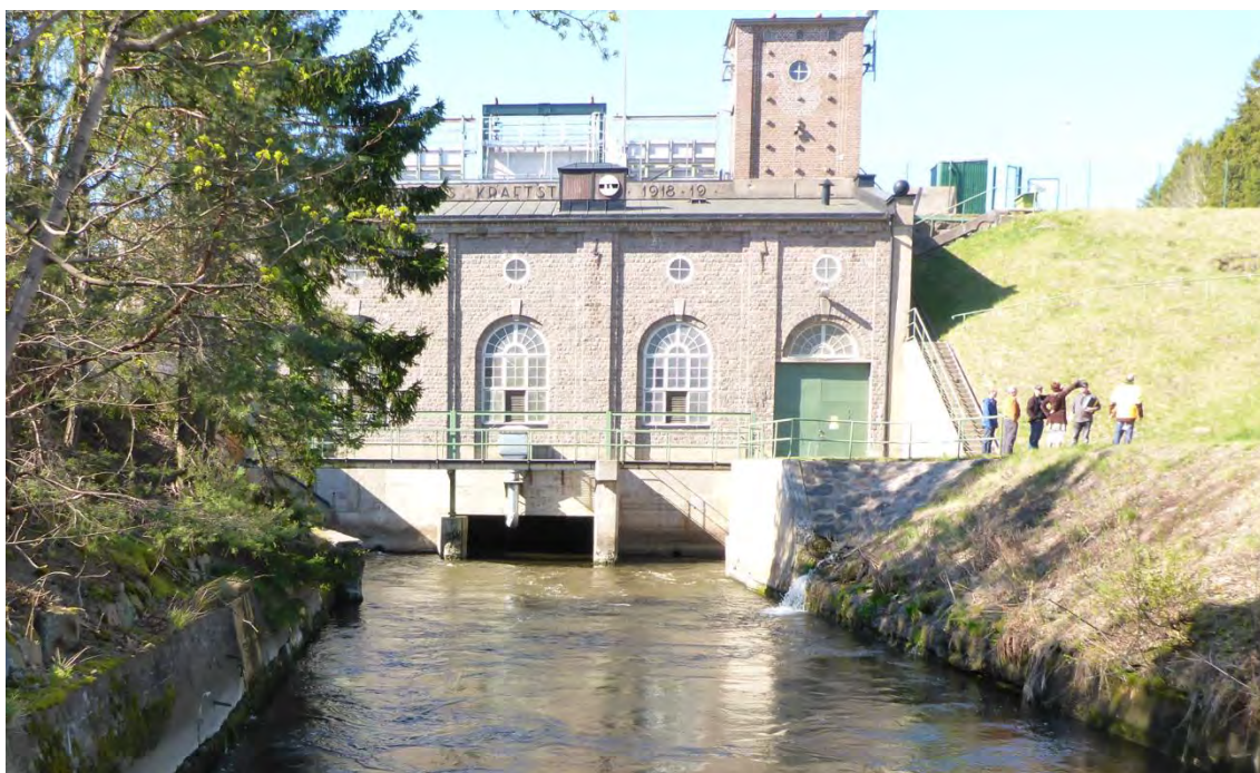
Uppströmsvy mot kraftverksbyggnaden i Svartåfors kraftverk 2014-04-22.
