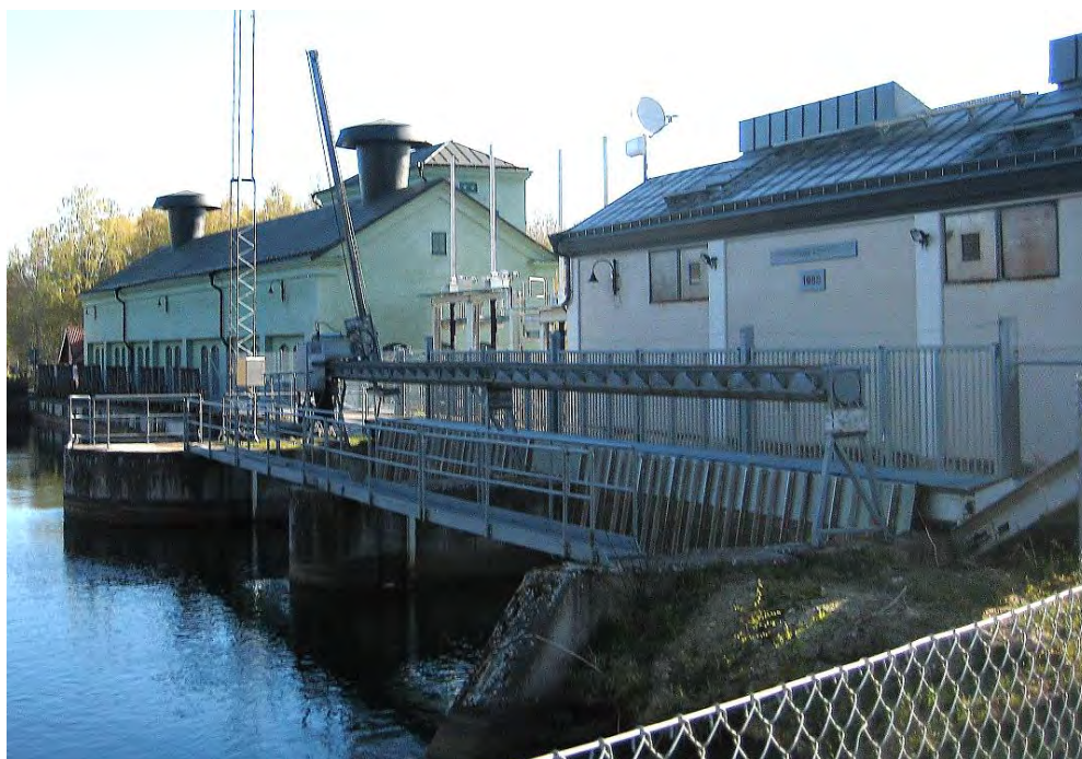
Nedströmsvy mot nya (främre) och gamla kraftverksbyggnaderna vid Borensberg 2014-04-24.
