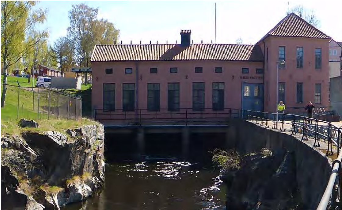
Uppströmsvy mot kraftverksbyggnad i Mjölby 2014-04-23.
