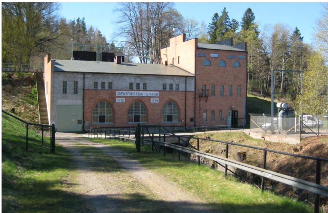
Uppströmsvy mot kraftverksbyggnaden i Odensfors 2014-04-22.
