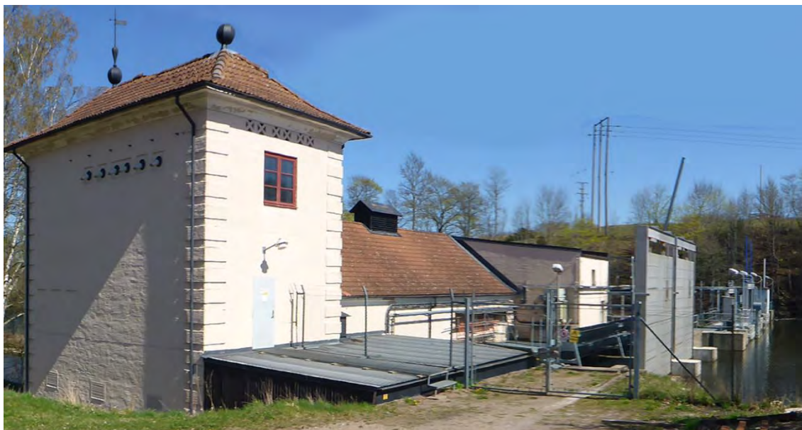
Nedströmsvy mot kraftverksbyggnad och damm i Vågforsen 2014-04-23.
