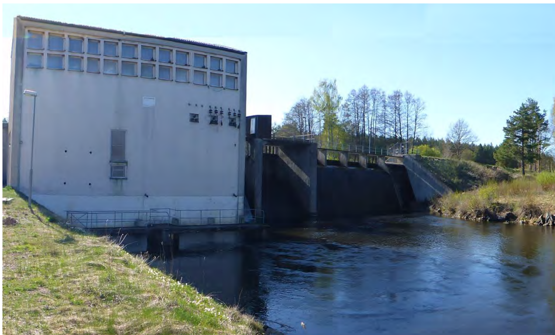
Uppströmsvy mot kraftverksbyggnad och damm i Knutbro 2014-04-23.
