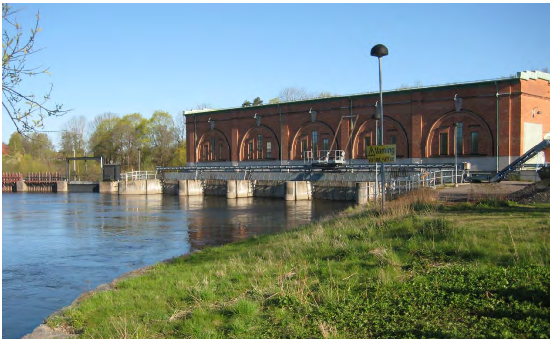
Nedströmsvy mot turbinintagen vid Fiskeby kraftverk 2014-04-23.
