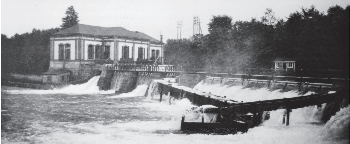
Bild 18. Nykvarns kraftstation fotograferat från norra stranden. Byggnaden till vänster är kraftverket där turbinerna är placerade och konstruktionerna i förgrunden är spilldammen. På fotografiet syns även fiskvägen som tidigare fanns vid kraftstationen. Från Carstensson m fl (1992).
