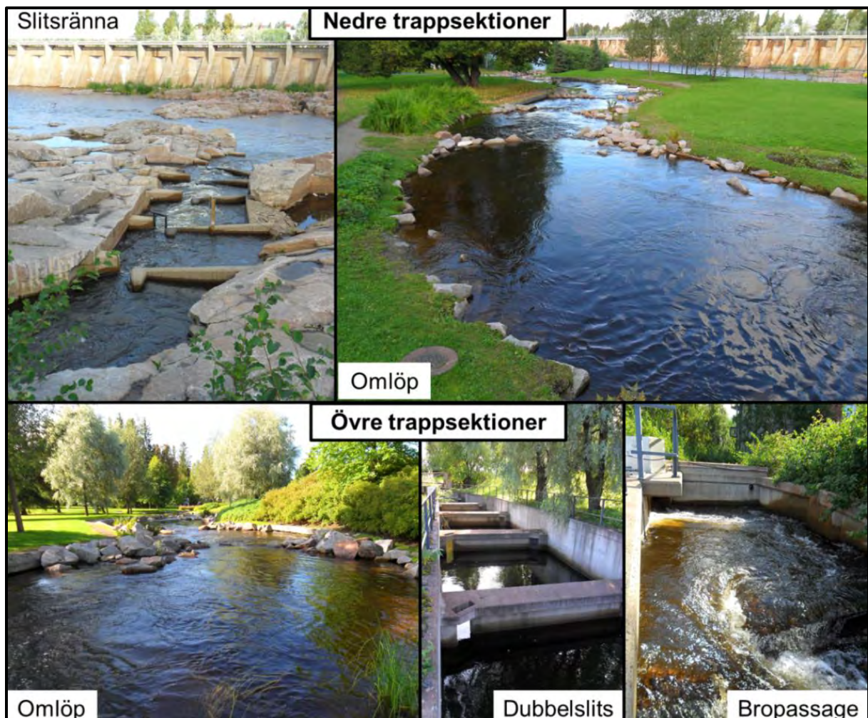
Figur 3. Exempel på ett omlöp med teknisk in- och utgång vid Oulujoki i Finland.
