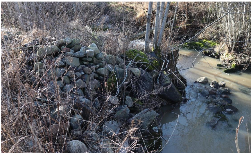
Figur 54. Stenmaterial som ligger i anslutning till vägtrumman. Foto: Rickard Gustafsson.
