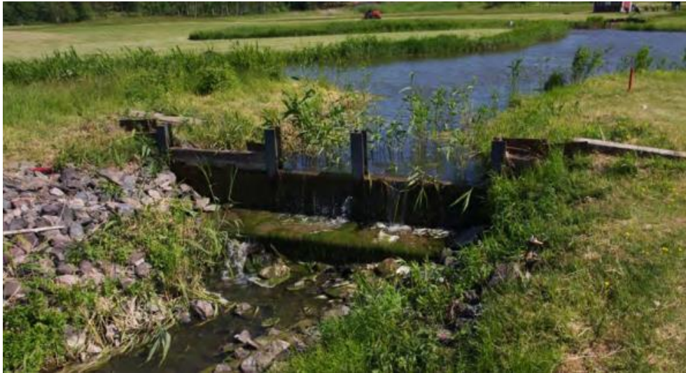
Figur 76. Dammen som dämmer upp bäcken och utgör ett definitivt vandringshinder för fisk. Foto: Olof Engstedt.
