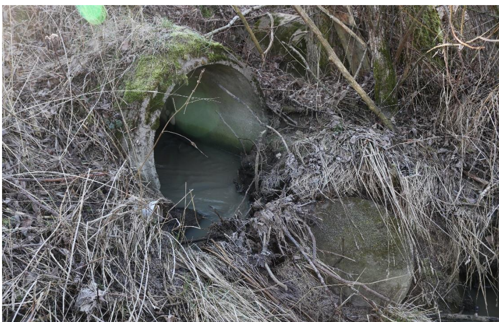
Figur 69. Bild på vägtrumman som utgör en svår passage för fisk. Foto: Rickard Gustafsson.
