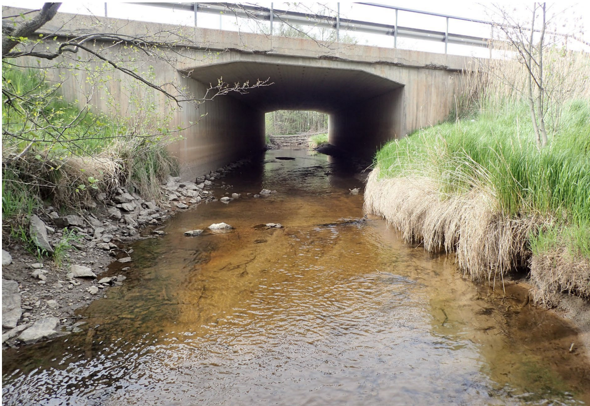
Bild 9. Pjältåns passage under E4:an inom de nedre delarna av åtgärdsområde 2. Passagen bedöms kunna orsaka problem för utter och andra däggdjur. Vägarna är hårt trafikerade och fungerande strandpassage eller annan möjlig passager förbi vägområdena saknas. Foto Jonas Edlund 2017-05-22.
