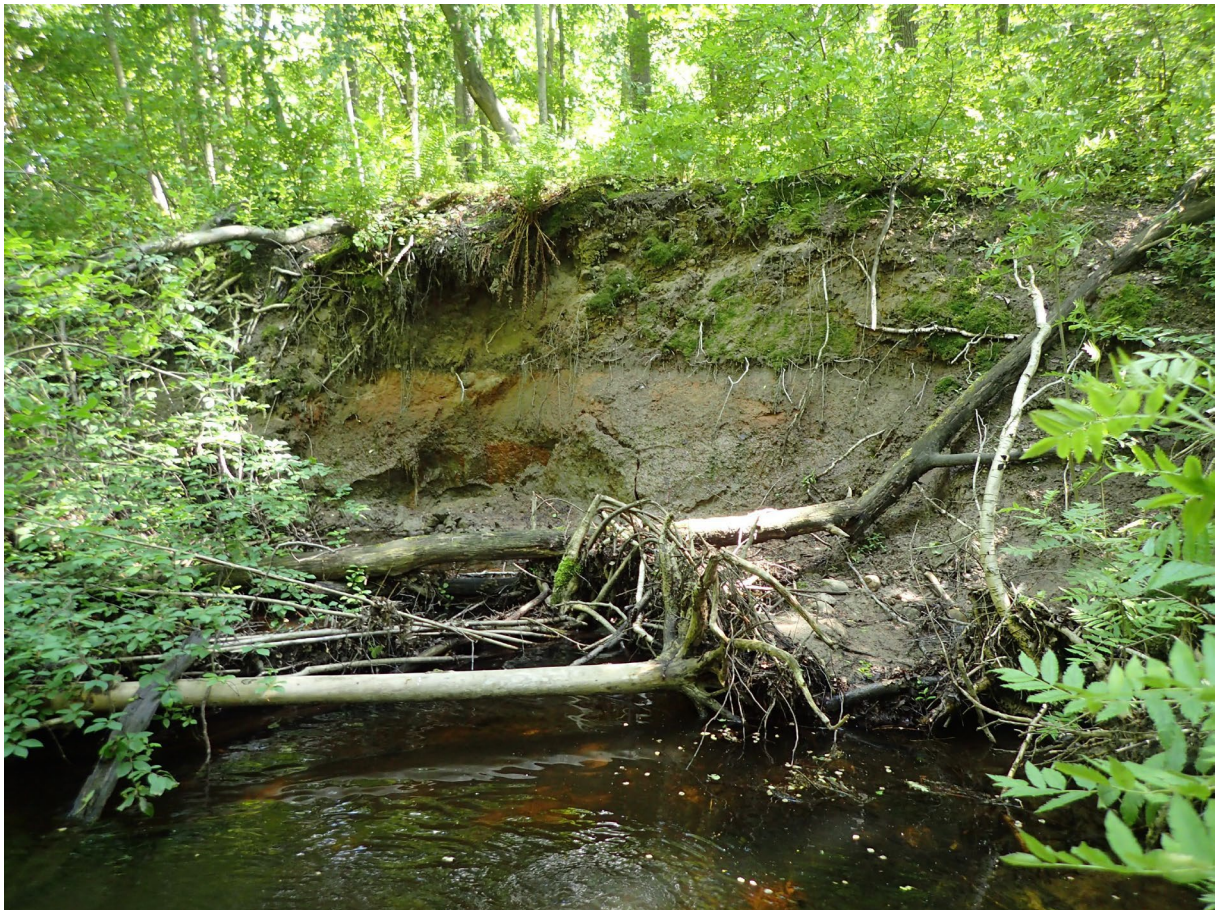
Bild 22. Kraftigt erosionsskadad strand med blottlagd mineraljord nära nedströms den långa kulverten inom åtgärdsområde 6 i Pjältån. Denna och andra liknande branta strandbrinkar är särskilt viktiga för kungsfiskare (VU), som nyttjar branterna som häckningslokaler. Kungsfiskare har pekats ut som en kommunal ansvarsart och Pjältån är en av de viktigare häckningslokalerna. Särskild hänsyn till kungsfiskarens häckningslokaler bör därför tas vid åtgärdsarbetet. Foto Jonas Edlund 2017-06-11.
