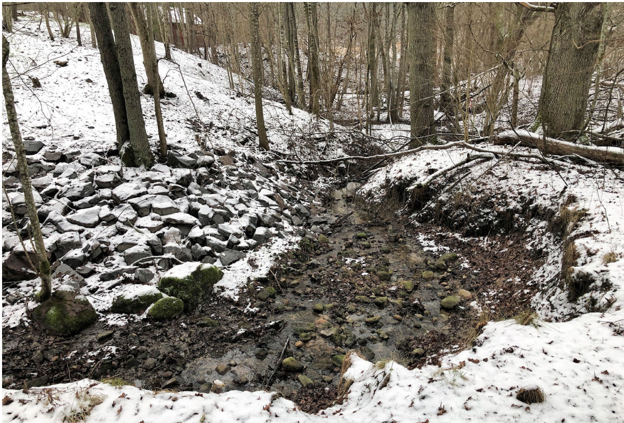
Bild 48. De övre delarna av Hultåns passage genom Auroraparken. Dessa delar är här med stor sannolikhet tillkommit i samband med kulverteringen och de omfattande schakt- och utfyllnadsarbeten som utförts inom åtgärdsområdet uppströms. Hösten 2012 drabbades sträckan av omfattande erosions-skador i samband med ett höglöde. Under 2020 erosionssäkrades strandzonen med grovt krossmaterial. Foto Jonas Edlund 2021-01-08.
