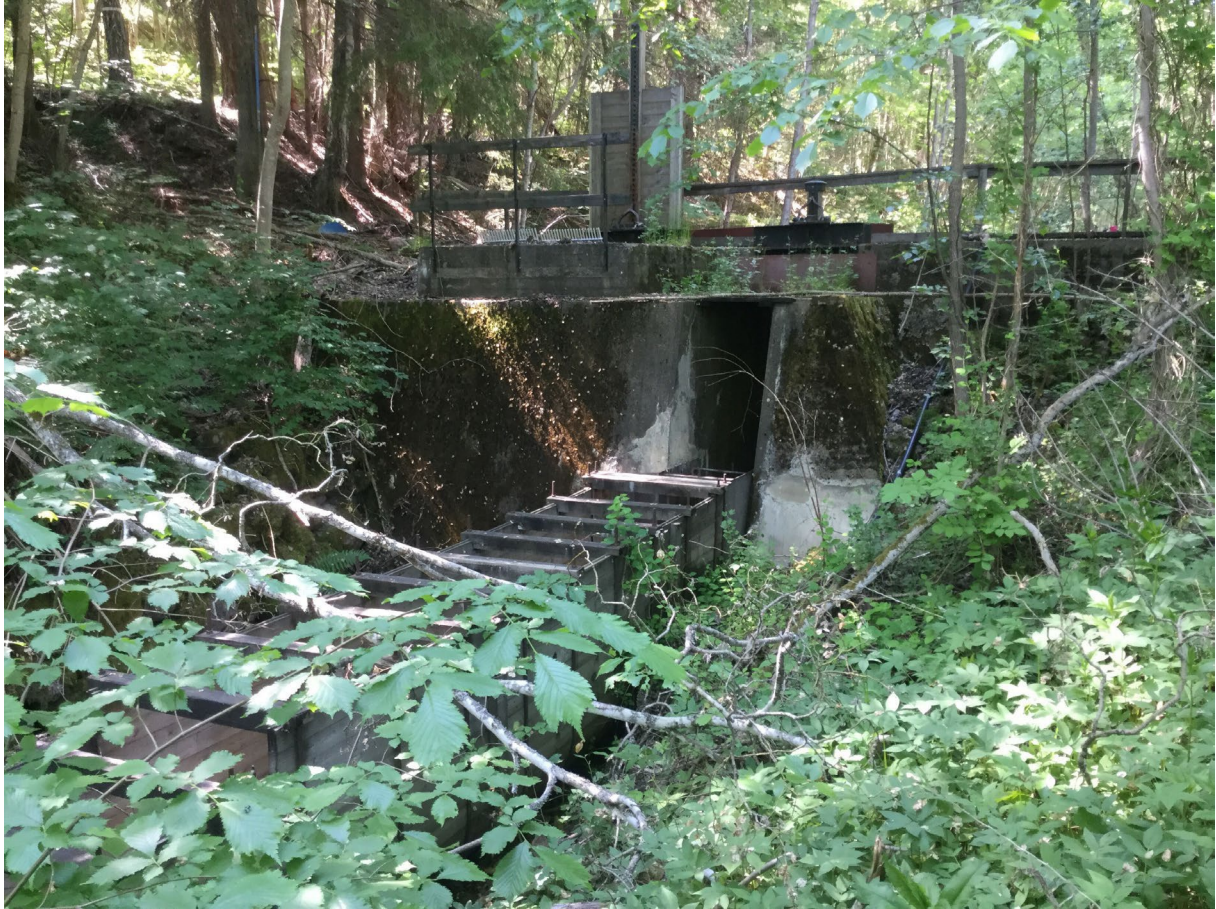
Bild 50. Dammen 160 meter nedströms Hultåns utlopp ur Ågelsjön. Dammen reglerar nivån i Ågelsjön och flödet i spillvattenfåran och fungerar som intag till den cirka 700 meter långa tuben ner till Hults kraftstation. Minflödet till spillvattenfåran släpps genom trärännan i förgrunden. Foto Jonas Edlund 2016-06-06.
