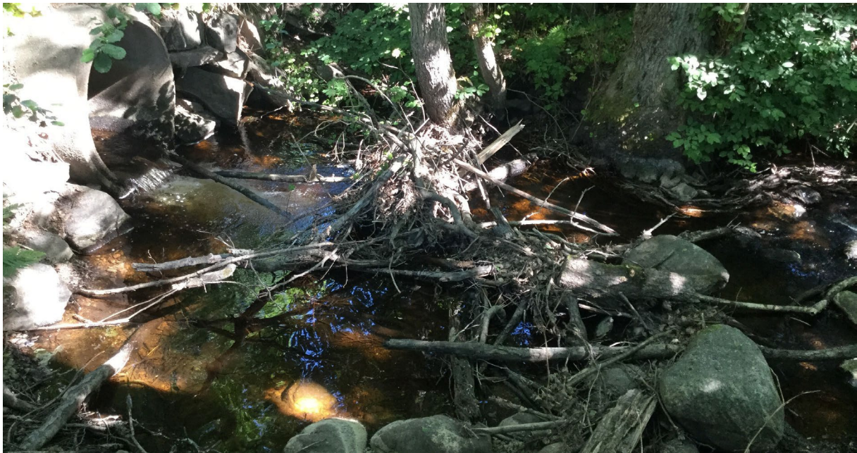
Bild 45. Trumman under vägen mot Yxbacken inom de övre delarna av åtgärdsområde 13 i Hultån. Foto Jonas Edlund 2016-06-06.
